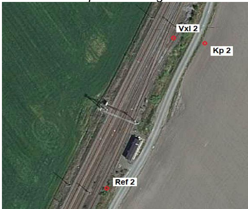
Foto 2: Växel 2 på nedspår vid Ledsgård i nordlig riktning mot Göteborg. Mätpunkterna är markerade med röda cirklar.
