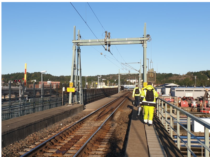
Foto 3: Vy från spåret mot den gamla Marieholmsbron och Hisingen
