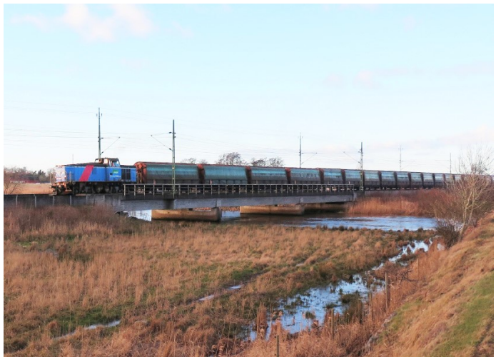
Foto 11: T44 diesellok med godsvagnar från Värö pappersbruk passerar den långa betongbron över ån Viskan
