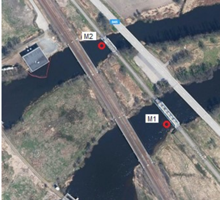
Foto 8: Järnvägsbroarna vid Åskloster där Väst kustbanans dubbelspår passerar över ån Viskans båda förgreningar. Mät punkt M1 och M2 är markerade med röda cirklar.
